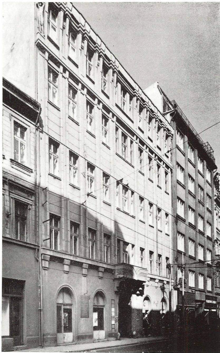
Lidový dům v Karlíně (Sokolovská 13, čp. 17), v němž bylo v letech 1923 až 1938 ústředí KSČ, kde pracoval Klement Gottwald (v demolici)
