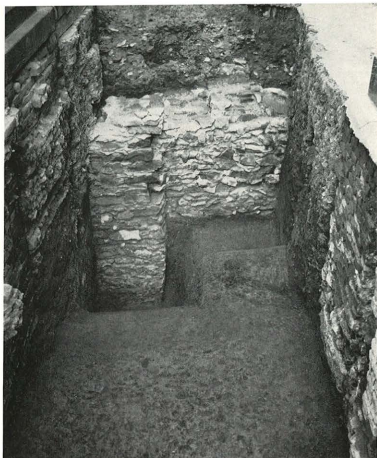
Zdivo neznámé věžovité stavby na vyšehradském hřbitově (snímek B. Nechvátal)
