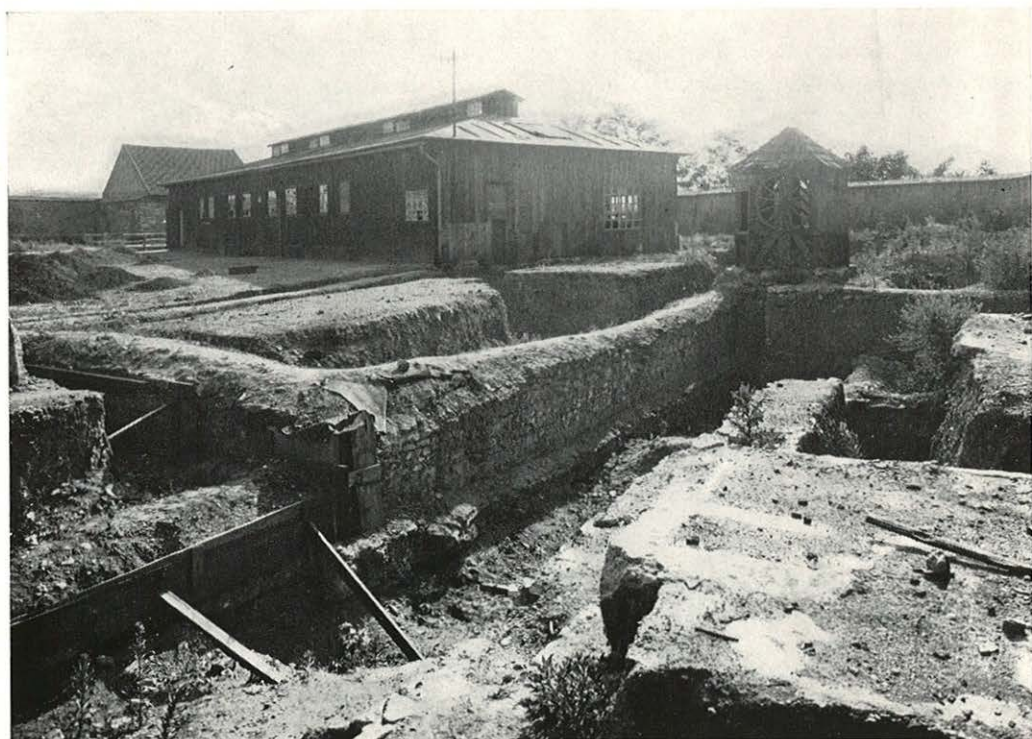
Odkryv zdiva tzv. „palácové“ budovy v severní části (reprodukce B. Nechvátal)
