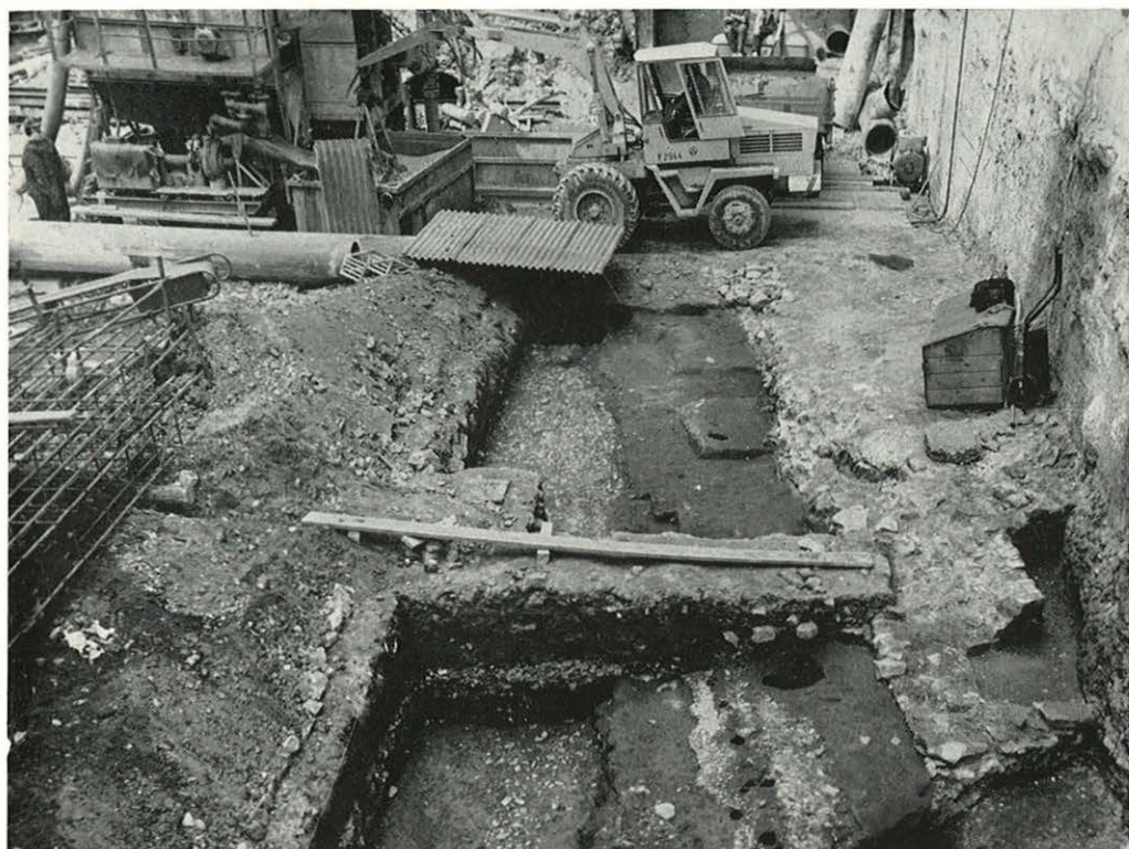
Výzkum na staveništi vestibulu metra v Kaprově ulici, kde se pod vysokými násypy zachytila kamenem vysypávaná cesta od brodu k tržišti, na jejím okraji zbytky pletených plotů a zahloubených objektů. (Snímek J. Janatková)
