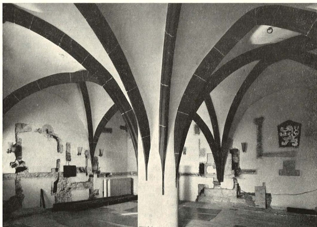
Klenba ve středním poli náměstního traktu v dolním mázhauzu (snímek M. Posselt)
