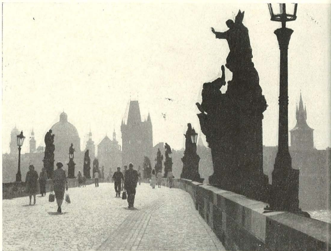
Karlův most, 2. polovina 14. a začátek 15. století (snímek J. Janatkové)
