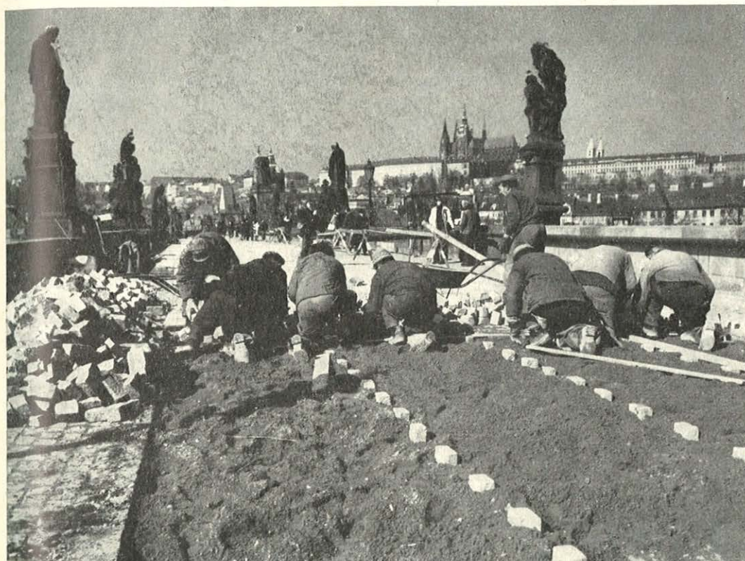
Obnova Karlova mostu, 1966–1976 (snímek J. Janatková)
