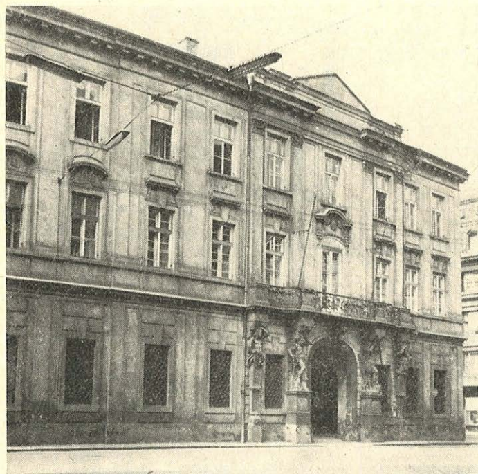
Průčelí bývalé čelnice čp. 587/I v Celetné ulici (snímek J. Muk)
