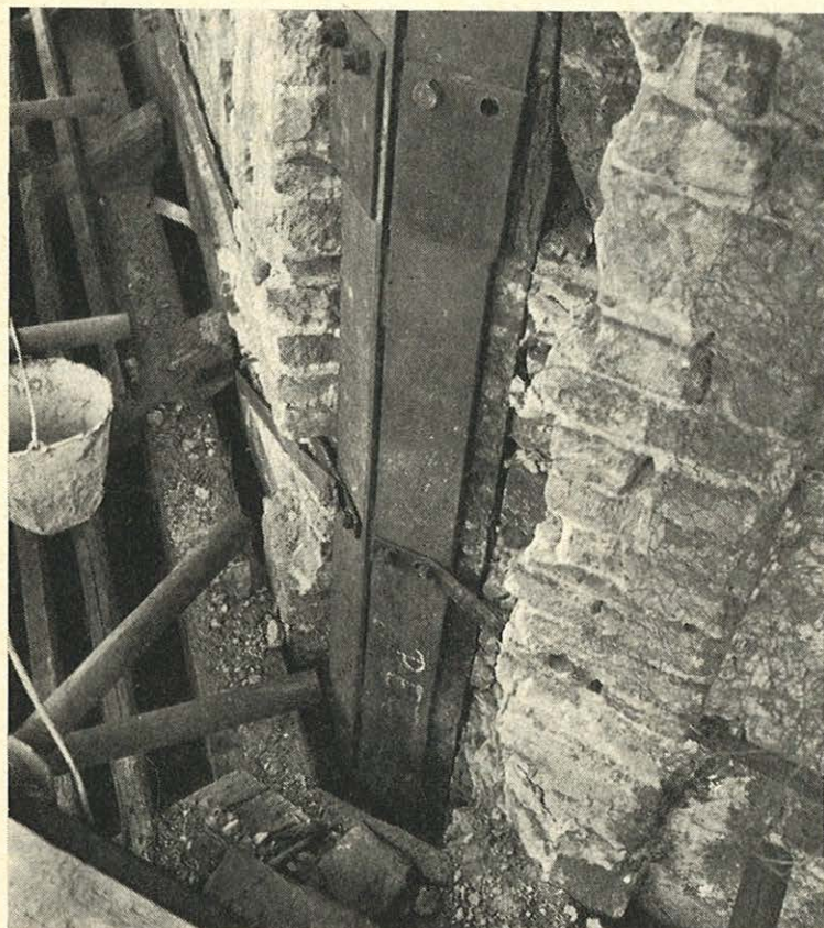
Vložená ocelová konstrukce — detail svislého pruhu s částí zavětrování (snímek H. Šantl)
