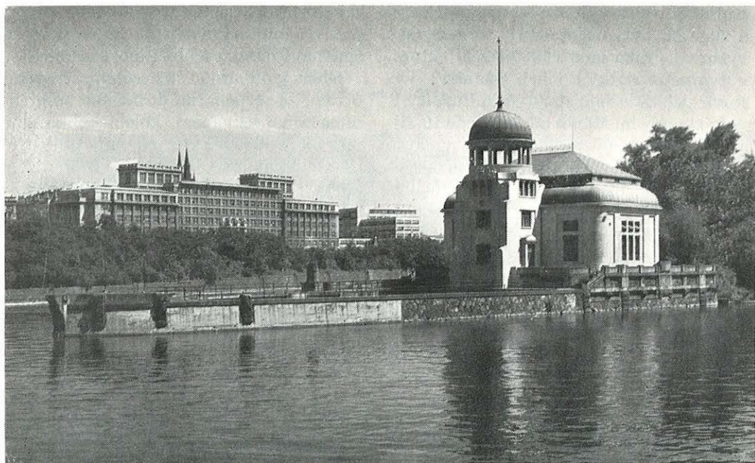
Vodní elektrárna na ostrově Štvanici — arch. Josef Dlabáč, 1912 (snímek Z. Helfert)
