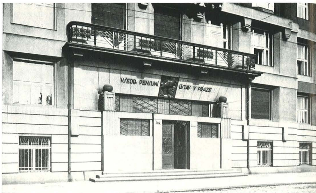
Portál bílého Všeobecného penzijního ústavu na Engelsově nábřeží — arch. Jan Kotěra a Josef Zásche, 1912—1913 (snímek Štencův archiv)
