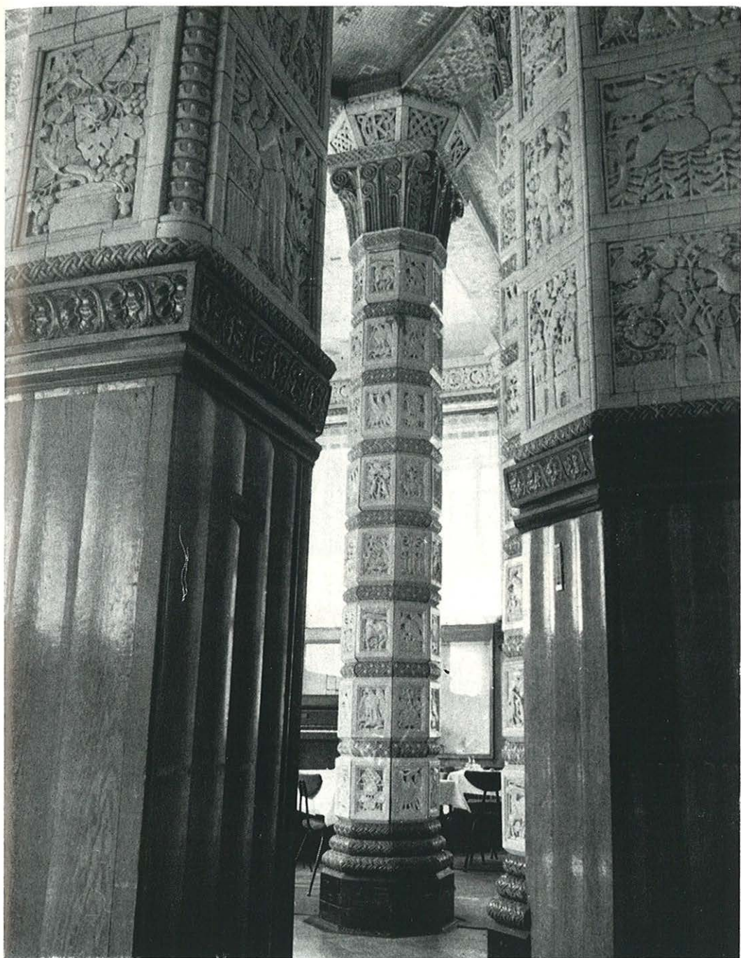
Dům rekreace ROH na Poříčí (býv. hotel Imperial), keramické obložení jídelny — arch. Jaroslav Benedikt 1913—1914 (snímek D. Uldrychová)
