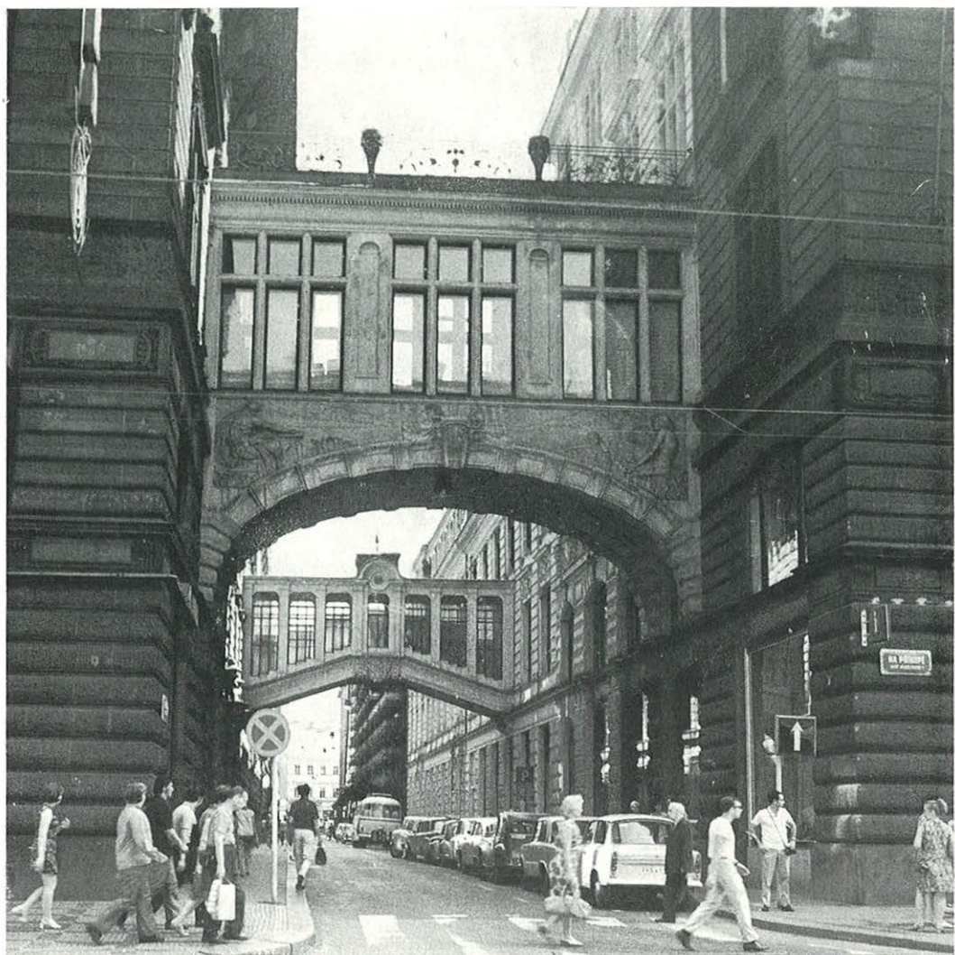
Přemostění ulice Nekázanky mezi dvěma bankovními domy — arch. Osvald Polívka, 1911—1912 (snímek D. Uldrychová)
