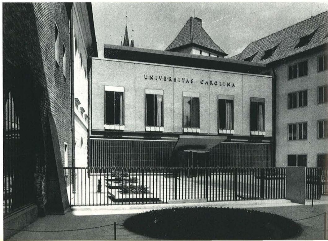
Nový vstup do Karolina — arch. Jaroslav Frágner, dokončeno 1968 (snímek Z. Helfert)
