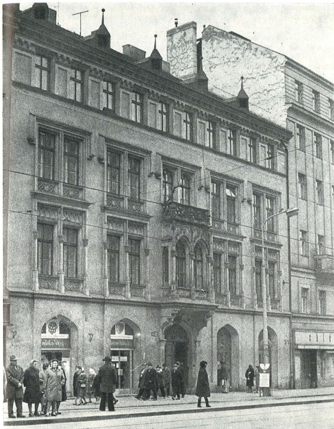
Čp. 1061/II na Novém Městě — arch. J. Kudláček (snímek D. Uldrychová)
