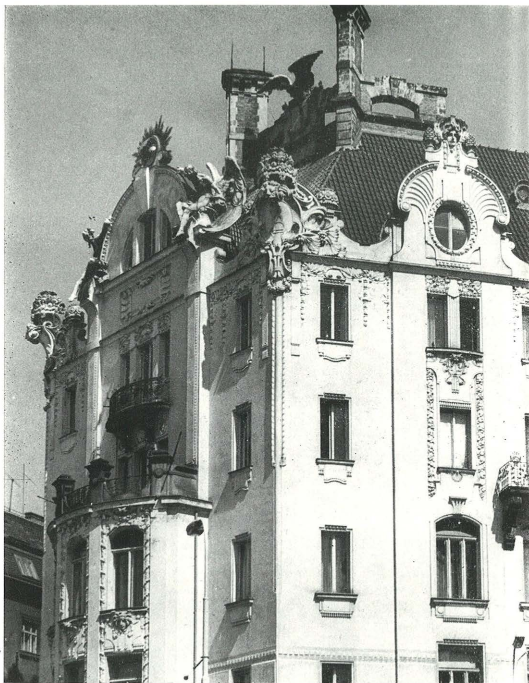
Budova býv. zajišťovacího úřadu na Gottwaldově nábř. — arch. Jiří Stibral, plastická výzdoba L. Šatouna 1902 (snímek J. Janatková)
