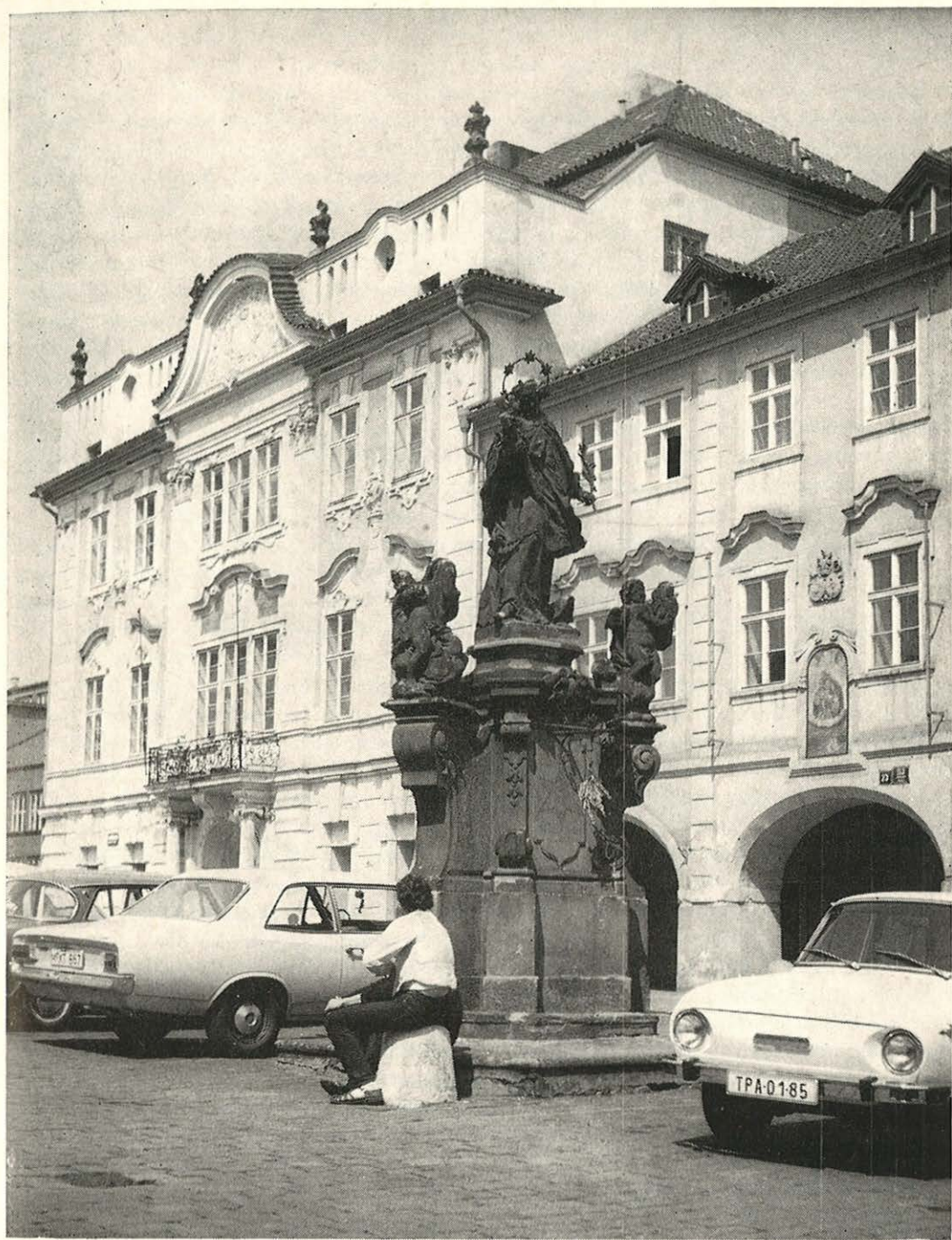
Kučerův palác na Pohorelci po obnově (snímek Z. M. Zenger)
