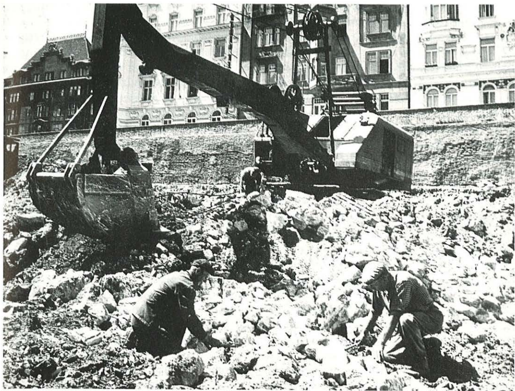
Stavební bagr rozebírá nejstarší vrstvy pražského ghetta, odkryté pod sklepy domů demolovaných pro stavbu Interhotelu, poslední příležitost k poznání této severní části ghetta nenávratně mizí, stavebně archeologický výzkum je v takovém prostředí již úsilím zcela problematickým (snímek Z. M. Zenger)
