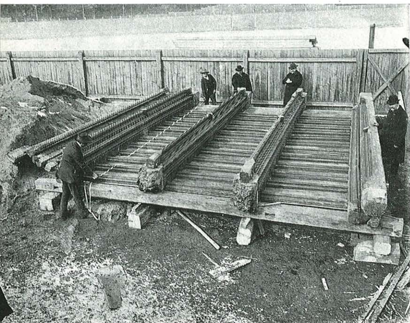
Dokumentace zachraňovaných částí likvidované památky: oměťování gotického stropu s bohatě profilovanými trámy ze zbořeného domu čp. 16/I v Praze (snímek J. Kříženecký 23. 2. 1909, Archív hl. m. Prahy)
