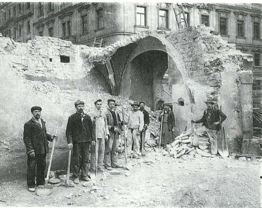
Dokumentace likvidované památky: demolice středověkého domu čp. 16/I v Praze, zbytky románského obvodového zdiva a gotické klenby (snímek J. Kříženecký 18. 3. 1909, Archív hl. m. Prahy)
