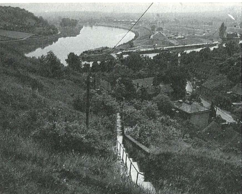
Císařský ostrov v Praze-Podbabě po výstavbě čistící stanice a Vltava po regulaci a rozšíření koryta; pohled z r. 1968. V popředí schodovitá stezka, kdysi hlavní pěší spojka mezi Suchdolem a Podbabou i Prahou (snímek J. Janatková)
