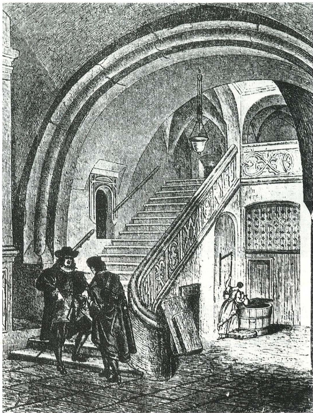
Nástup na pozdně gotické schodiště z vestibulu (reprod. K. Kibic)
