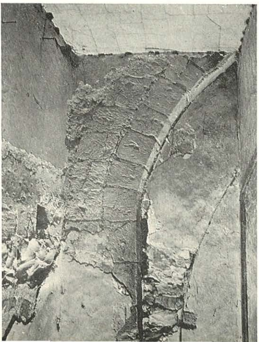
Býv. kostel sv. Vavřince pod Petřínem na Újezdě, pohled na zbytek severní části východního románského podvěžního oblouku, vpravo část gotického triumfálního oblouku, vlevo osekaná římsa a nad ní zbytky valené klenby románského podvěží (foto J. Janatková)
