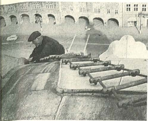
Práce na krytině kostela sv. Mikuláše na Malé Straně
