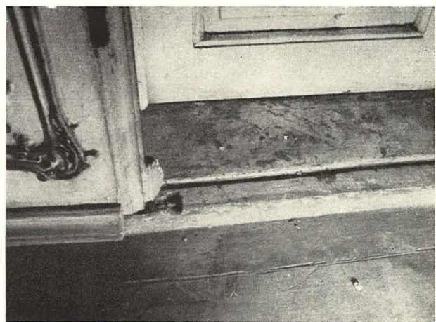
Arcibiskupský palác — jižní průčelí — stružka pro dešťovou vodu
