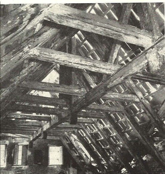
Renesanční krov věšadlové soustavy v severním křídle čp. 261/III (Snímky J. Vajdiš)
