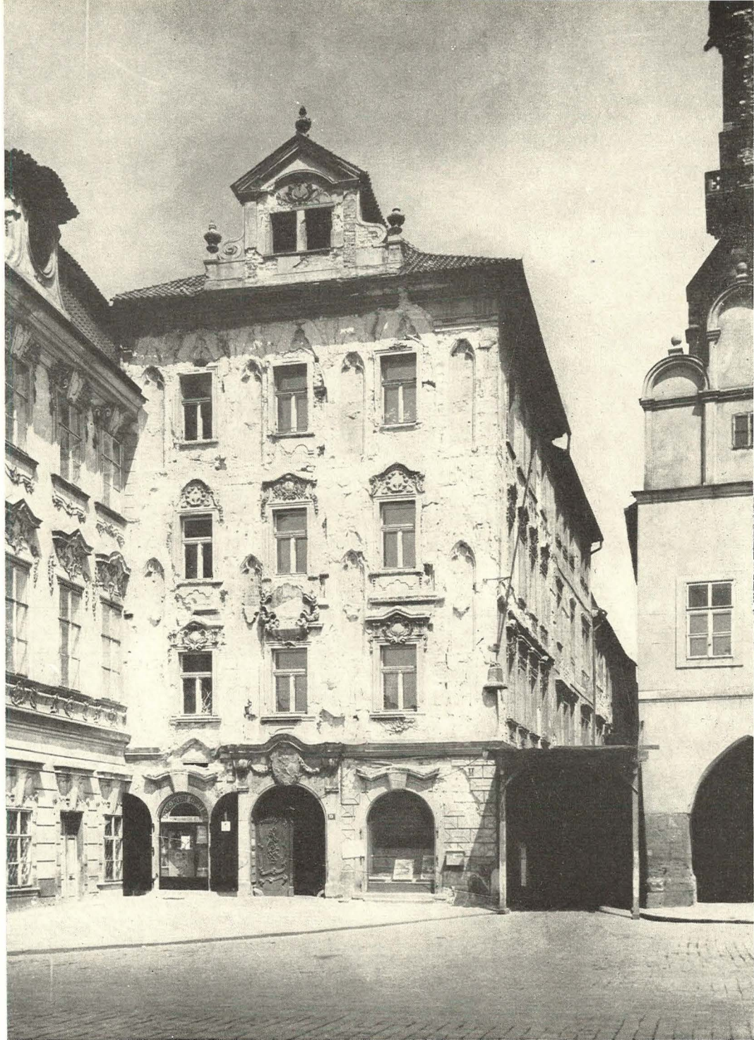
Dům U zvonu s odkrytou gotickou fasádou (Snímek K. Kibic)
