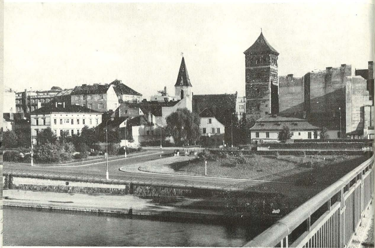
Současný stav zástavby na předmostí Švermova mostu. Snímek: K. Kibic
