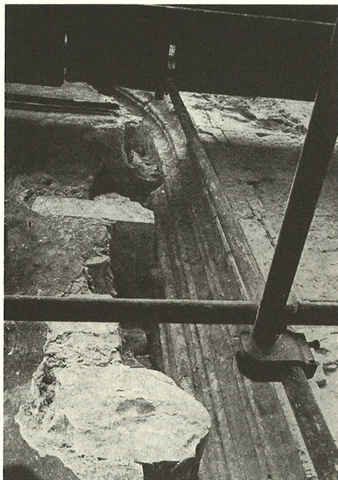
Saský dům čp. 55/III v Mostecké ulici — odkrytá část okna původního gotického paláce. Snímek: Jitka Janatková
