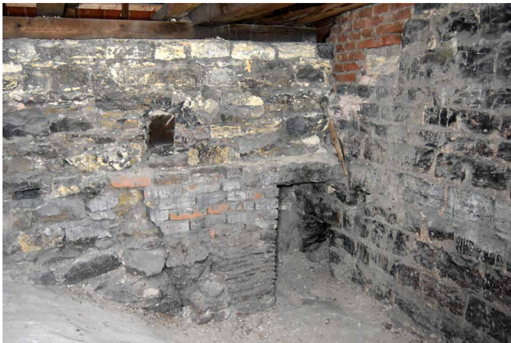
Obr. 7. Anežský klášter, presbytář kostela sv. Františka. Pohled do jihozápadního kouta podkroví na styk jižní obvodové zdi presbytáře z lomového kamene a východního štítu lodě kostela sv. Františka z pravidelných kvádrů z 30. let 13. století (foto autor, 2024).
