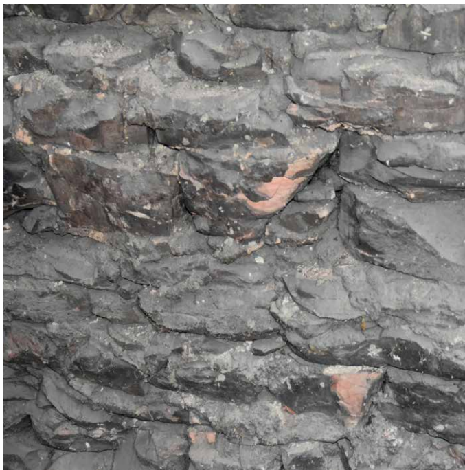
Obr. 13. Anežský klášter, podkroví presbytáře kostela sv. Františka. Narůžovělá barva opuky ve vrstvě A dokládá, že tato vrstva byla vystavena ohni (foto autor, 2024).
