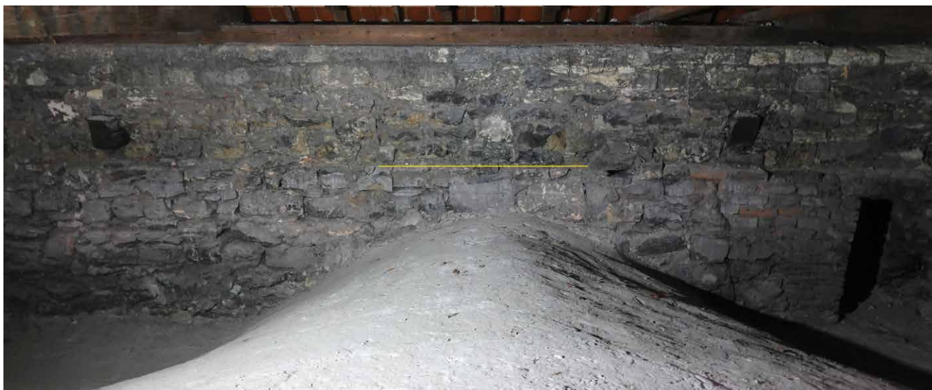
Obr. 11. Anežský klášter, podkroví presbytáře kostela sv. Františka. Vrchol klenby a zdivo A z první stavební fáze (1238–1245), žlutě ložná spára zdiva B z přestavby po roce 1300 (foto autor, 2024).
