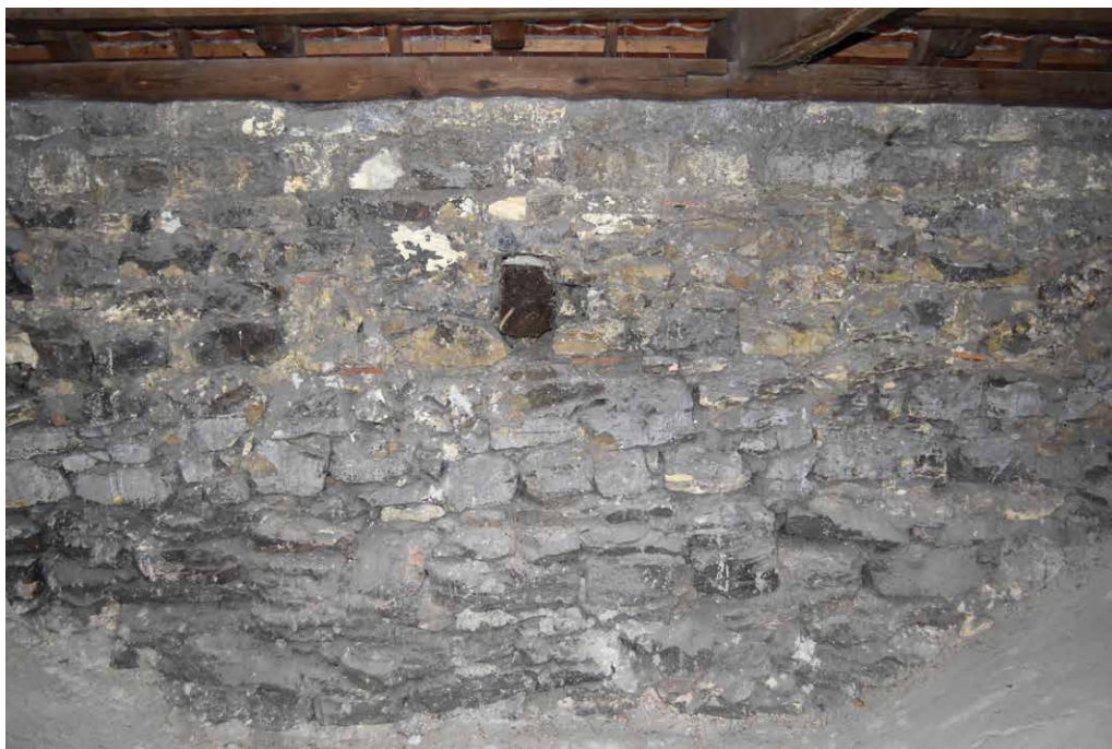
Obr. 8. Anežský klášter, podkroví presbytáře kostela sv. Františka. Líc jižní obvodové zdi nad rubem klenby s odříznutým zbytkem trámu ztužující konstrukce (foto autor, 2024; neupraveno).
