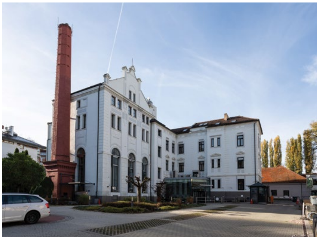
Obr. 4. Praha 5-Košíře, čp. 2, parostrojní pivovar a sladovna A. Lanner. Pohled od severovýchodu ze dvora, vlevo bývalá varna s komínem, vpravo administrativní budova (foto M. Kracík, 2023).
