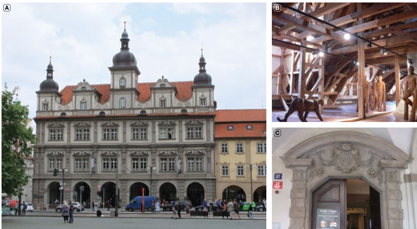
Obr. 2. Praha 1-Malá Strana, čp. 35, Malostranská radnice. A – pohled od západu z náměstí; B – prostor krovu sloužící kultuře; C – raně barokní vstupní portál v podloubí na náměstí (foto A+C: J. Baláček, 2023; B: R. Gája, 2010).
