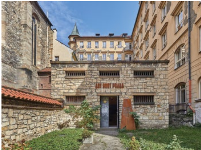
Obr. 30. Praha 2-Nové Město, čp. 300, ppč. 1141/3, Dittrichova. Průčelí bývalé regulační plynové stanice z 50. let 20. století (foto O. Němec, 2023).
