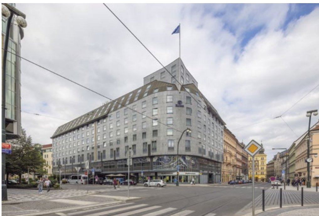
Obr. 6. Praha 1-Nové Město, čp. 2079/II, V Celnici 7, Havlíčkova 9, hotel Penta, projekt hotelu Státní projektový ústav obchodu Brno, 1989–1990, návrh průčelí Aleš Lang – Libor Jebavý – Josef Holeček, 1991–1993 (foto M. Micka, 2025).
