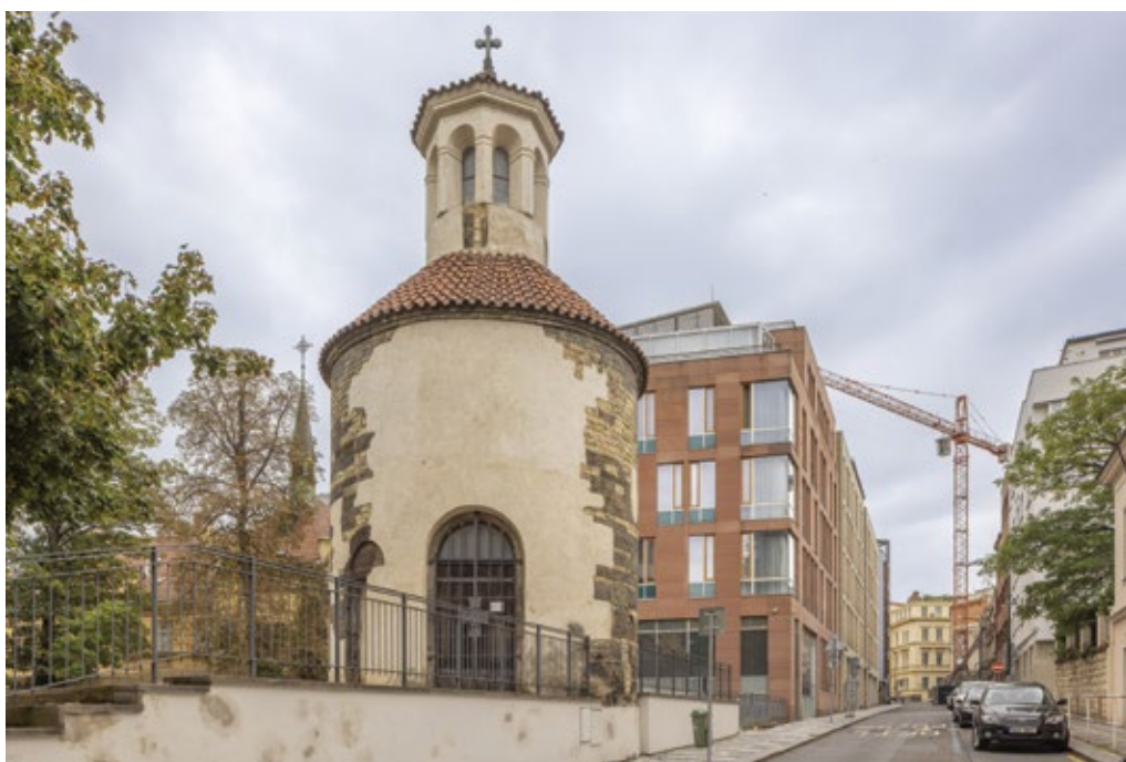
Obr. 27. Praha 1-Nové Město, čp. 1329/II, Na Rybníčku 5, Longin Business Center, Martin Kotík – Luděk Jasiok – Stanislav Krčmárik, 1998–2000, pohled z ulice Na Rybníčku, v popředí románská rotunda sv. Longina (foto M. Micka, 2025).
