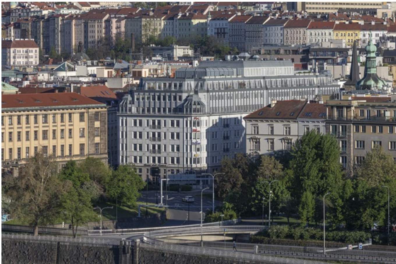
Obr. 13. Praha 1-Nové Město, čp. 1216/II, Petřská 19, Samcova 4, Klimentská 12, Mlynářská 3, Prague City Center, Otto Dvořák, 1992–1995 (foto M. Míka, 2025)
