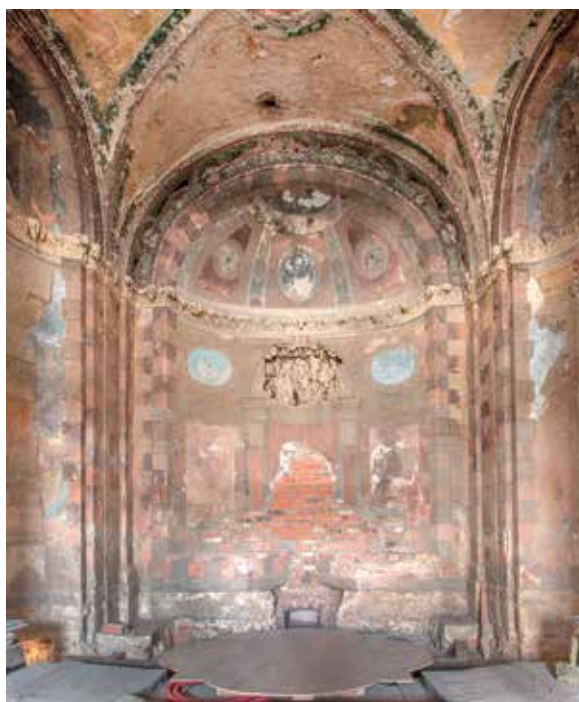
Obr. 15. Praha 7–Bubeneč, čp. 20, Šlechtova restaurace. Zadní nika grotty s druhotným vyzděním, iluzivními oky, fragmenty po bazénku a odtokovým kanálkem. Na podlaže hypotetický půdorys bazénku z dřevotřísky (foto P. Havlík, 2018).
