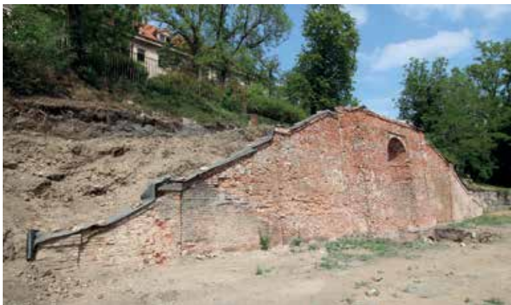
Obr. 11. Praha 2-Nové Město, klášter Na Slovanech (Emauzy), jižní zahrada ppč. 1237/1 – zahradní opěrná zeď s nikou a vodním prvkem. A – celek; B – detail niky s bazénkem a jímkou (foto K. Knotová, 2018).
