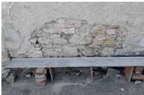
Obr. 17. Praha 8-Březiněves, Na Hlavní čp. 1. A – část severní stěny barokního jižního křídla s fragmentem bloku zdiva s psaníčkovým sgrafitem; B – detail druhotně použitého fragmentu zdiva s psaníčkovým sgrafitem (foto M. Kovář, 2019).
