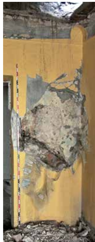
Obr. 6. Praha 1-Nové Město, Soukenická čp. 1091/II, uliční křídlo, 1. patro, cihelný pas, fragment topeniště (foto K. Knotová, 2018).
