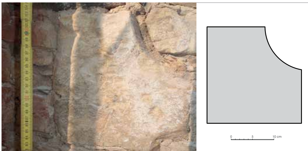
Obr. 5. Zlatníky u Prahy, kostel sv. Petra a Pavla. Gotický prvek probraný výžlabkem osazený v západním průčelí a schéma jeho profilace (foto a terénní skica M. Kovář, 2018; překreslil M. Semerád, 2019).
