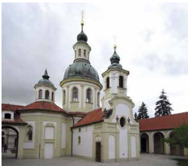
Obr. 2. Praha 17-Řepy, poutní areál s kostelem Panny Marie Vítězné na Bílé Hoře. Pohled na kostel od jihovýchodu (foto J. Baláček, 2019).
