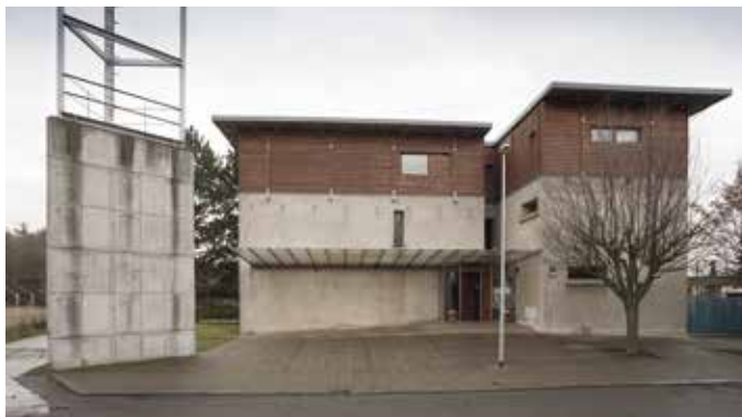
Obr. 3. Praha 8-Kobylisy, čp. 1264, U Školské zahrady 1, kostel ČCE U Jákobova žebříku. Severní fasáda a hlavní vstup (foto M. Kracik, 2018).
