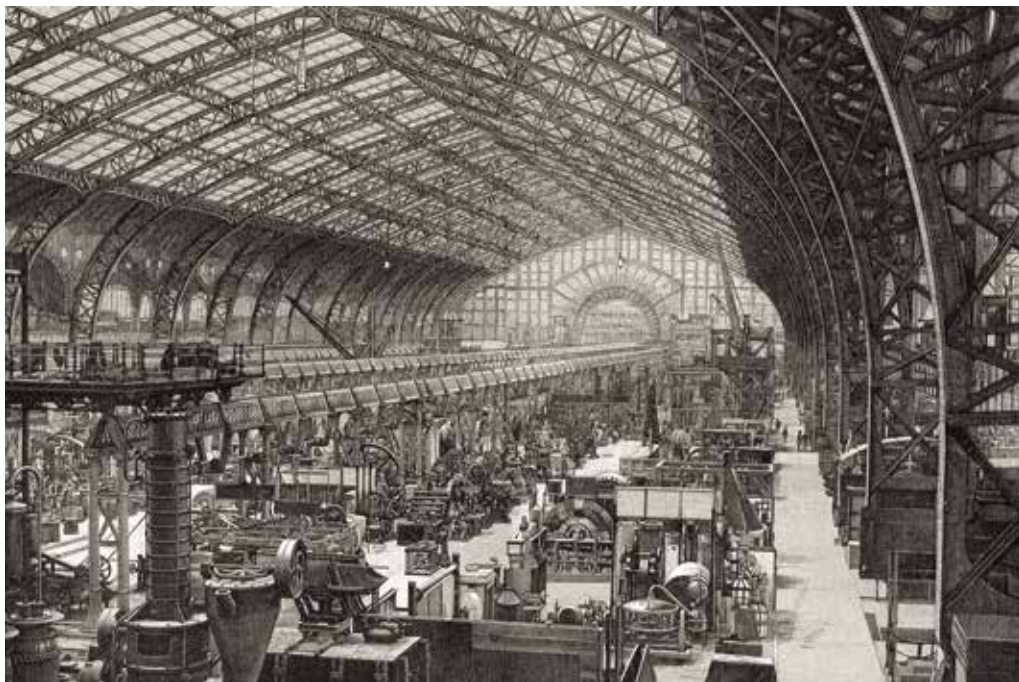
Obr. 18. Galerie des Machines (Palác strojů) na Pařížské světové výstavě v roce 1889. Celkový pohled do interiéru (převzato z MONOD 1890/1, 249).
