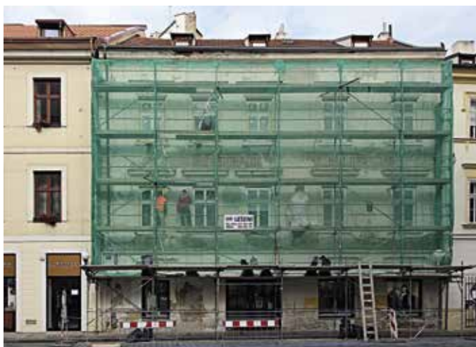
Obr. 8. Praha 1-Staré Město, čp. 665, Královská 9. Uliční fasáda v průběhu opravy (foto L. Bartoš, 2017).
