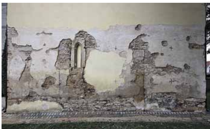
Obr. 12. Praha-Královice, kostel sv. Markéty, východní fasáda kostela v průběhu opravy (foto L. Bartoš, 2017).
