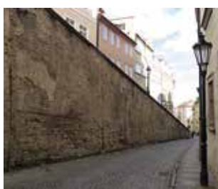
Obr. 1. Praha 1-Malá Strana, Thunovská, jižní opěrná zeď Nových zámeckých schodů. Celkový pohled (foto A. Kusáková, 2017).
