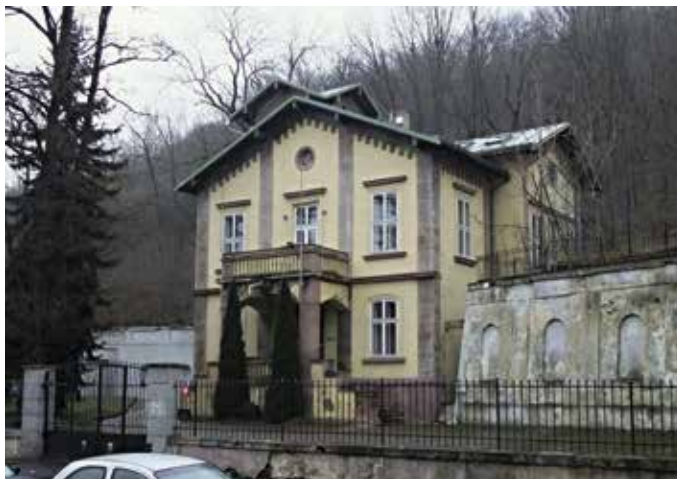
Obr. 5. Praha 4-Podolí, čp. 448, ředitelská vila Podolské cementárny. Pohled od západu z Podolské ulice (foto J. Baláček, 2015).
