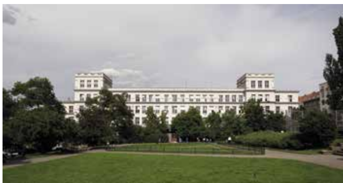
Obr. 6. Praha 3-Žižkov, čp. 1300, Státní ústřední škola bytového průmyslu. Pohled od západu ze Žižkova náměstí (foto M. Kracík, 2014).
