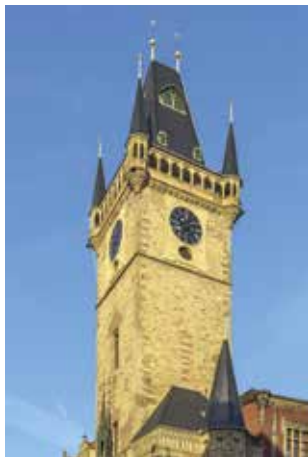
Obr. 1. Praha 1-Staré Město, čp. 1/1, Staroměstská radnice, věž. Pohled na věž po obnově (foto M. Frouz, 2018).
