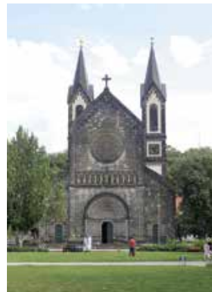
Obr. 1. Praha 8-Karlín, kostel sv. Cyrila a Metoděje. Celkový pohled z parku na hlavní průčelí (foto autorka, 2018).
