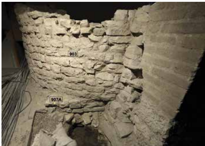
Obr. 11. Pražský hrad, kostel P. Marie. Pohled na vnější stranu kostela v místě napojení apsidy k lodi. Pod pravidelným zdivem apsidy (903) jsou základy starší fáze stavby a dochované dva řádky nadzemního zdiva (907A). Mladší fázi stavby patří kvádrkové zdivo s ohořelým pláštěm (903). SV nároží lodi (vpravo v popředí) bylo odbouráno vložím mladší novověké konstrukce. Rekonstrukce nároží je ukončena v horní části novodobým cihlovým zdivem. Pohled od S (foto © J. Gloc, 2017).
