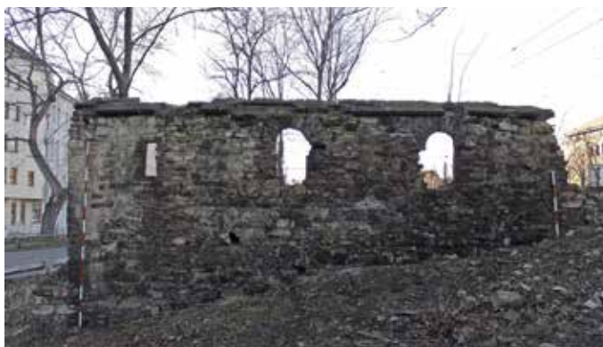
Obr. 17. Praha 2-Vyšehrad. Hradební zeď při objektu bývalé slupské strážnice. Celkový pohled na hradební zeď od jihu (foto H. Tomagová, 2015).
