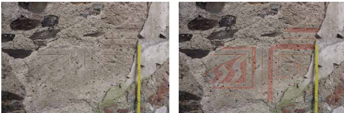
Obr. 18. Praha 15-Petrovice, zámek. Nález renesanční sgrafitové fasády objektu v západní části areálu – vlevo; digitální zvýraznění – vpravo (foto L. Bartoš, 2015).
