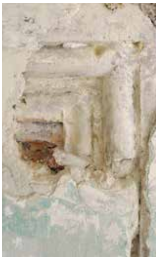
Obr. 14. Praha 1-Malá Strana, čp. 181/III. Bohatě profilované ostění okna v 1. patře. Šipka v plánu označuje umístění okénka; červeně pozdně gotická zdíva (foto z roku 2015 a zpracování plánu s využitím podkladu SURPMO M. Semerád, 2016).
