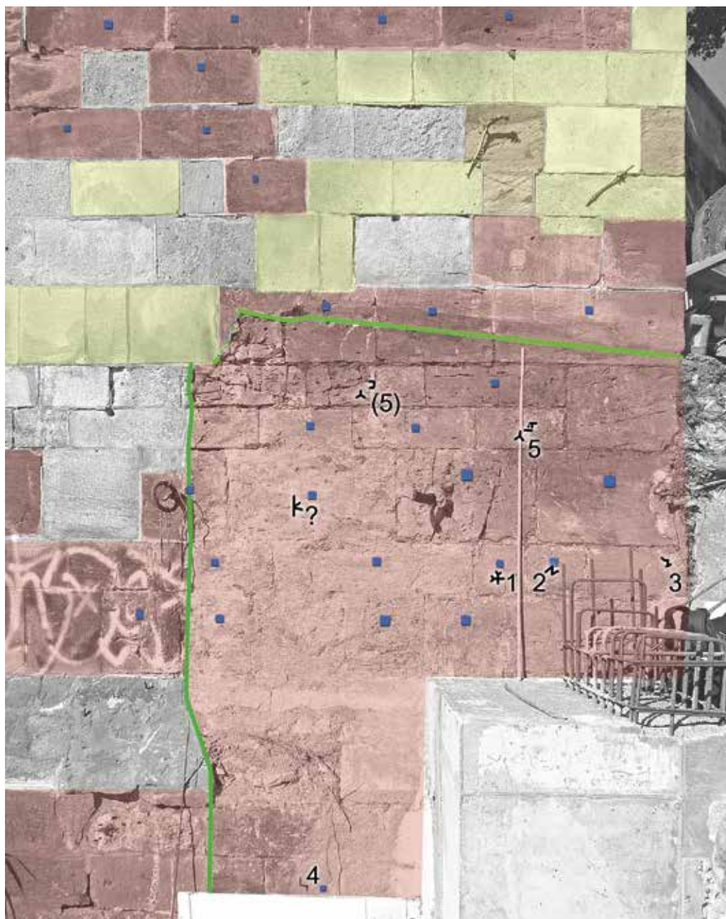
Obr. 13. Praha 1-Malá Strana, Karlův most. Dokumentace nálezů na SV ploše 10. pilíře.
