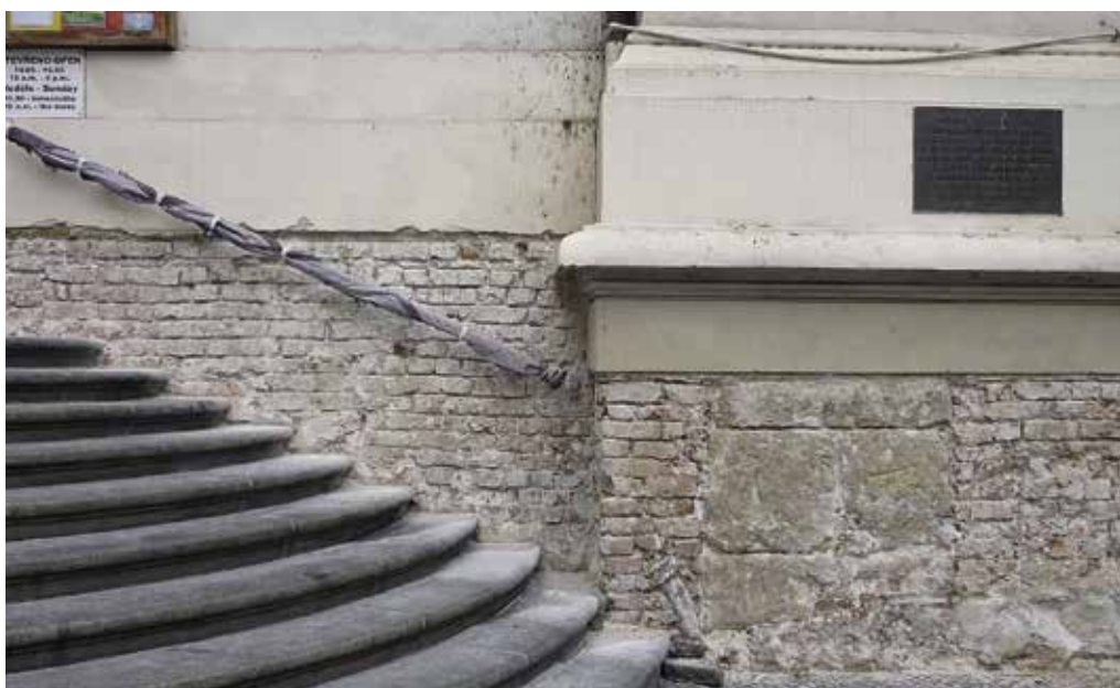
Obr. 3. Praha 1-Staré Město, kostel sv. Mikuláše, sokl západní fasády. Kamenný pilíř obklopený cihlovým zdivem (foto F. Záruba, 2014).
