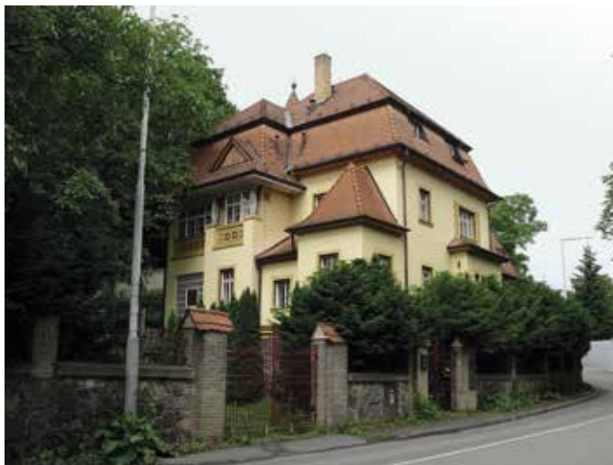
Obr. 6. Praha 16-Zbraslav, čp. 630, Storchova vila. Pohled od jihovýchodu z Bartoňovy ulice (foto J. Hájek, 2009).
