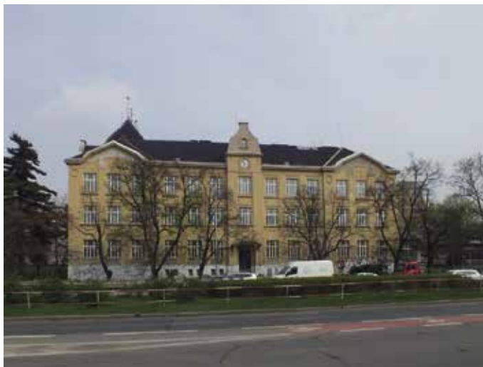
Obr. 5. Praha 10-Strašnice, čp. 200, areál školy. Celkový pohled od jihu z ulice V Olšínách (foto J. Baláček, 2013).
