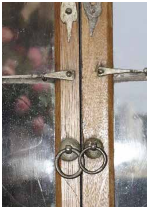
Obr. 23. Praha 1-Hradčany, kostel Panny Marie Andělské. Pohled na vinutý půlobrtlík prvku č. 6 (foto L. Bartoš, 2015).
