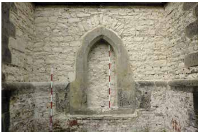
Obr. 5. Praha 2-Nové Město, kostel sv. Apolináře, jižní fasáda. Zazděný portál jižního vstupu s odhaleným zdivem lodi a opěráků (foto L. Bartoš, 2013).
