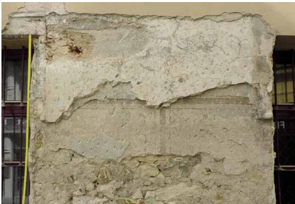
Obr. 4. Praha 1-Staré Město, čp. 735, nález renesanční sgrafitové fasády v Rámové ulici. Nálezová situace mezi okny v přízemí (foto L. Bartoš, 2013).
