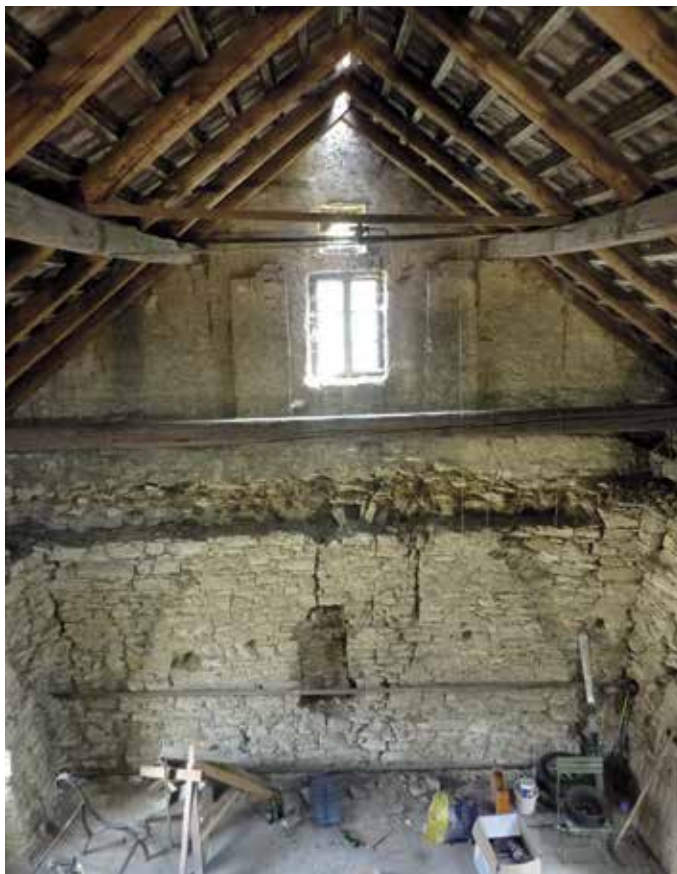
Obr. 6. Praha 6-Veleslavín, čp. 14, jižní prostora v patře. Průhled z podkroví do místnosti s odbouranou křížovou klenbou (foto L. Bartoš, 2013).
