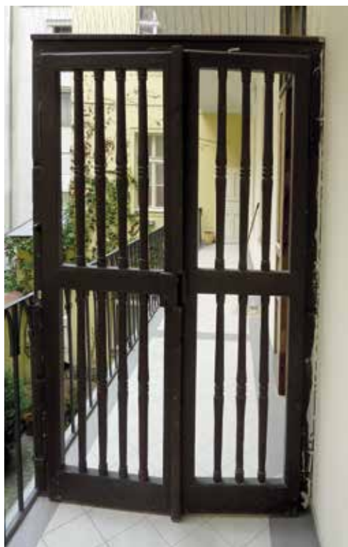
Obr. 18. Praha 1-Malá Strana, čp. 490, Velkopřevorské náměstí 1. Celkový pohled na prvek z pavlače (foto V. Bartošová, 2014).
