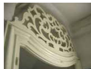
Obr. 20. Praha 1-Staré Město, čp. 592, Celetná 23. Pohled na světlík prvku z chodby (foto V. Bartošová, 2014).
