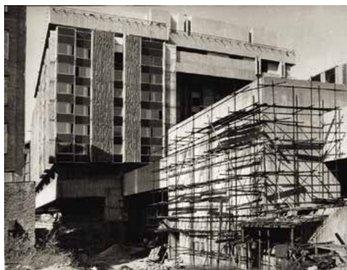
Obr. 12. Praha 1-Staré Město, čp. 43, Pařížská 30. Hotel Intercontinental, dobová fotografie z výstavby hotelu, fasádu člení vertikální pásy keramického obkladu (foto archiv hotelu, konec 60. let).
