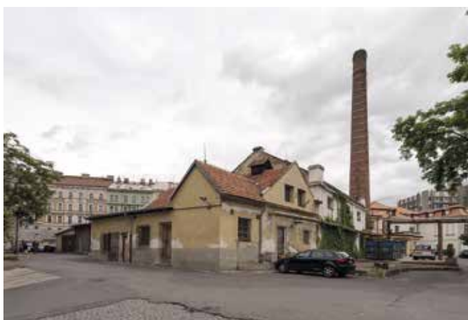
Obr. 5. Praha 2-Nové Město, parc. č. 1665, kotelna. Celkový pohled od západu (foto M. Kracík, 2014).
