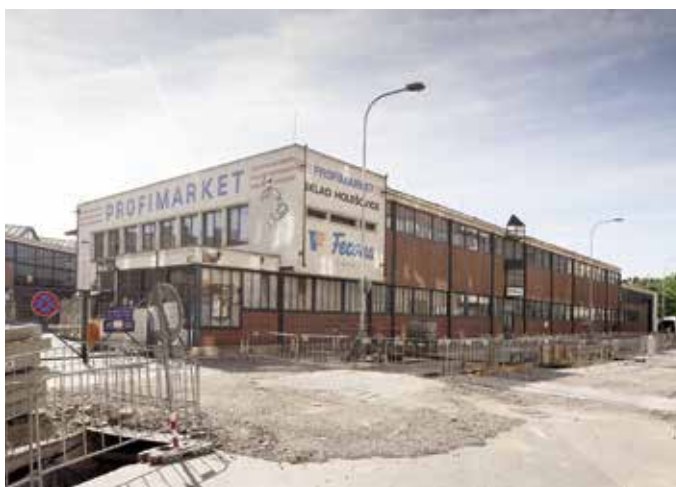
Obr. 9. Praha 7-Holešovice, čp. 1455, sklady Ferra – administrativní budova s bočním skladem a vrátnicí (foto M. Kracík, 2014).
