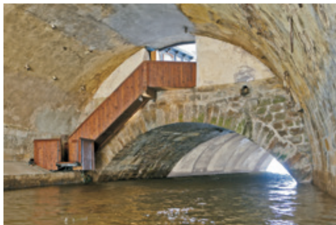
Obr. 6. Praha 1-Staré Město, Křižovnické náměstí, dochovaný oblouk Juditina mostu u staroměstského břehu. Šedě překryty mladší konstrukce. Pohled od jihu z prostoru vltavského ramene (foto M. Frouz, 2009).
