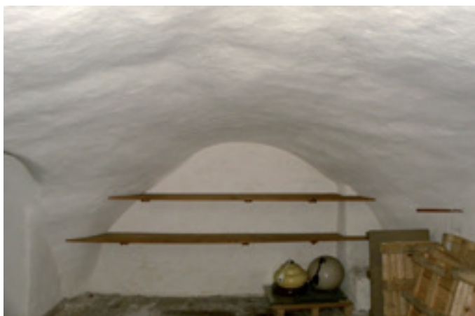
Obr. 3. Praha 1-Staré Město, Liliová 9, čp. 211/I, východní křídlo bývalého kláštera dominikánek. Raně gotická prostora zaklenutá bezžebornou křížovou klenbou při severním konci křídla (foto M. Kovář, 2011).
