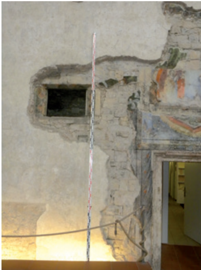
Obr. 15. Praha 1-Staré Město, kostel sv. Anny. Podhled na zachované fragmenty severní zdi východního rozšíření rotundy sv. Vavřince vystavěné z opukových kvádrů. Ve zdivu je možné pozorovat druhotně prolomený gotický a renesanční otvor, rovněž je zřetelná masivní plenta vyrovnávající rozdíl mezi ubíhající románskou zdí a lícem severní zdi presbytáře kostela sv. Anny. (foto M. Kovář, 2011).
